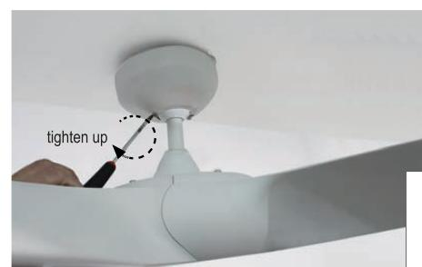
**ESP** Conecte el ventilador al soporte. Asegúrese de que las conexiones son correctas. Si tiene duda consulte con un técnico.
